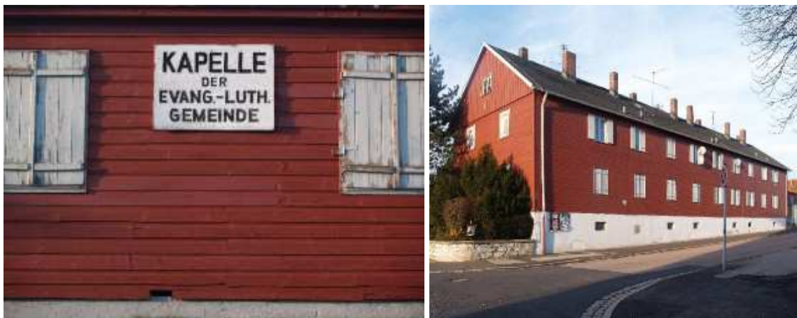
Abbildung 12 Fotos der denkmalgeschützten Gebäude innerhalb des Geltungsbereiches
