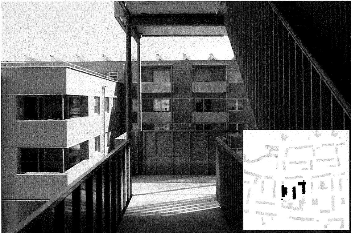
Die alte Tragstruktur wurde barrierefrei erschlossen und zu modernem Wohn-/ Büroangebot ausgebaut. Neue Gebäudehülle und Aufstockung bestehen aus vorgefertigten Holzelementen in Passivhausqualität, dazu Musterlösungen für Lebenszyklus- und Energiebilanz, Gebäudetechnik, Bauphysik, Statik, Brand- und Schallschutz, sowie effektiven Bauprozess. Nur ein altes Haus mußte weichen, mit dem Ersatz in Holzbau entstand ein neuer Gebäudetyp.
